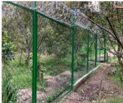
Malla de protección Aula Juan Rey costado norte Fuente: DGA – grupo de infraestructura
