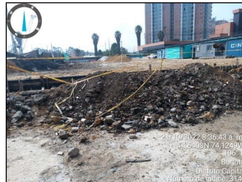
. Visita control Material susceptible de aprovechamiento acopiado, proyecto constructivo La Almería, PIN 21420.
