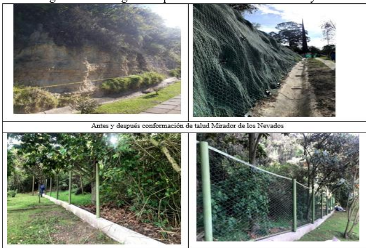
Ilustración 11: Obras de mitigación de riesgos Parque Mirador de los Nevados y Soratama
