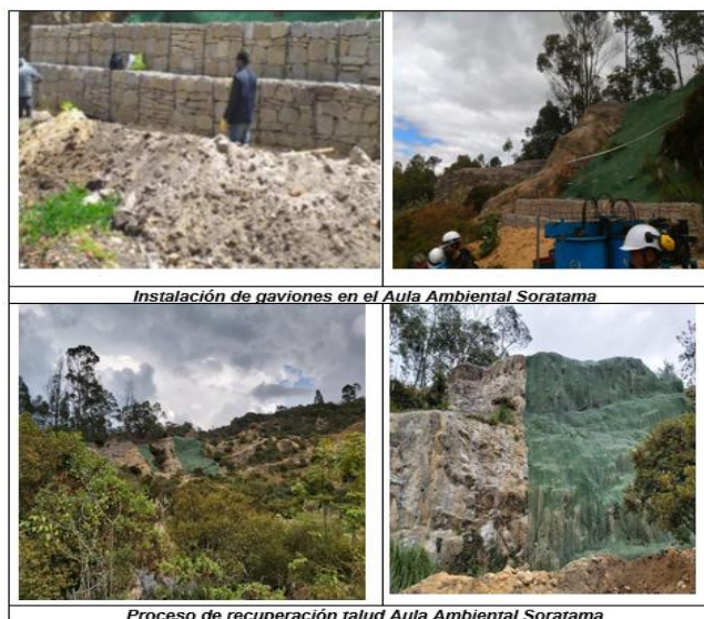
Ilustración 12: Procesos de recuperación del talud Aula Ambiental Soratama
