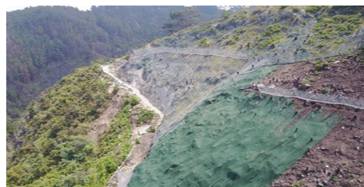
Avance de la obra en Monserrate.
