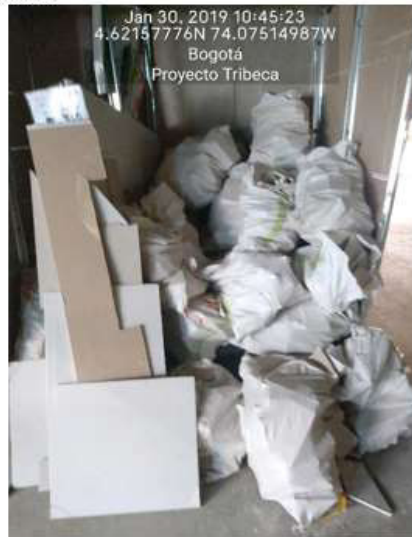
Fotografía No. 4. Acopio de material susceptible de aprovechamiento. Proyecto Tribeca
