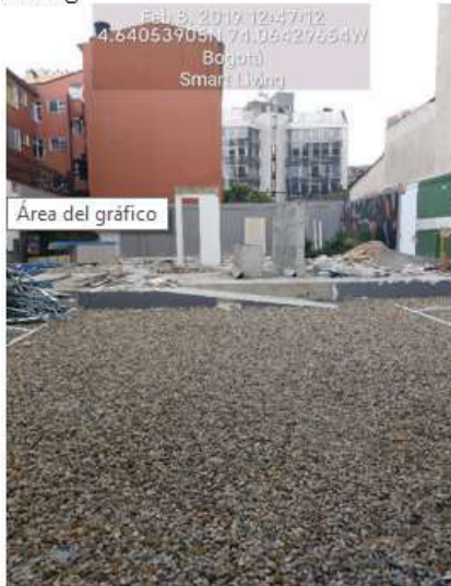
Fotografía No. 3. Etapa de demolición, generación de RCD. Proyecto Smart Living
