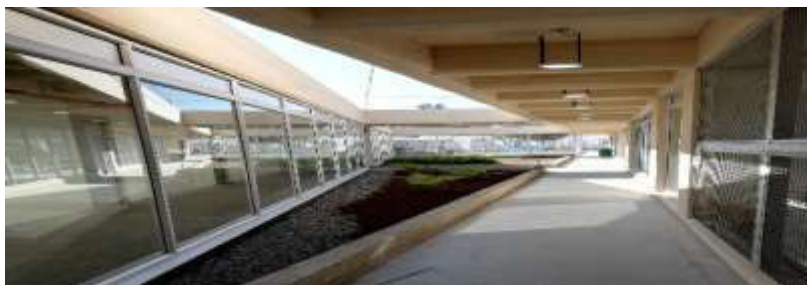
Ilustración 112. Bloque de hospital
