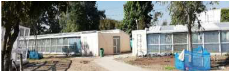
Ilustración 115. Bloques de cuarentena y mantenimiento de reptiles
