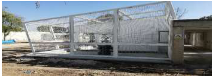
Ilustración 117. Bloques mantenimiento aves
