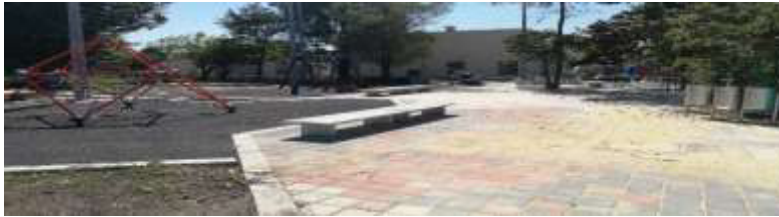
Ilustración 123. Otras instalaciones y obras exteriores
