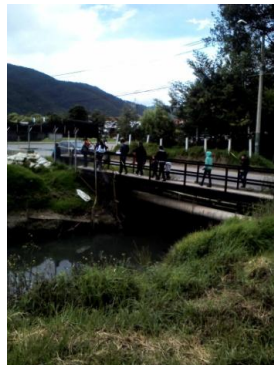
entrada de afluentes al humedal
