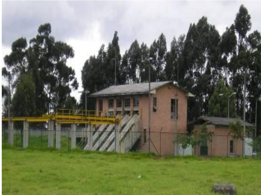
Foto:. Estación De Bombeo La Rivera..
