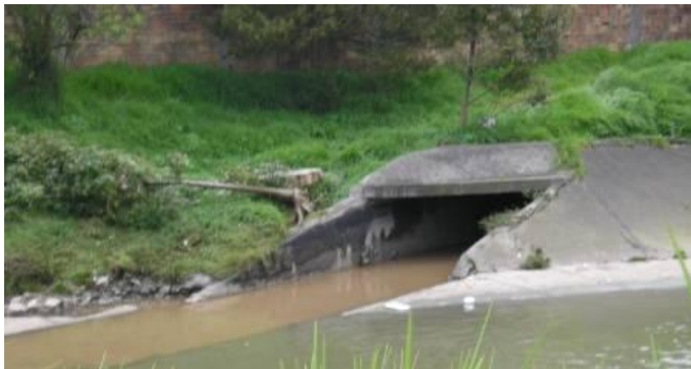
Foto: Descarga Colector aguas residuales al río Fucha,
