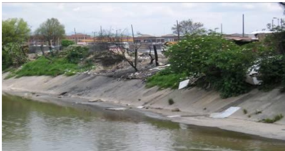
Foto:. Disposición de escombros sobre la zona de ronda (localidad de Fontibón),
