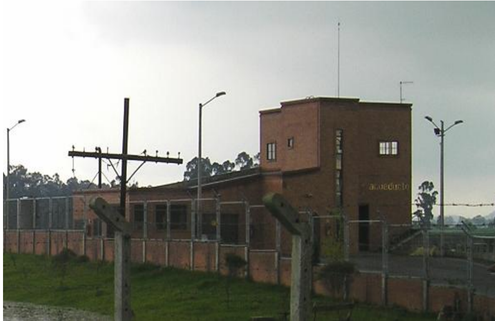
Foto.: Estación de Bombeo de aguas Lluvias. EAAB.
