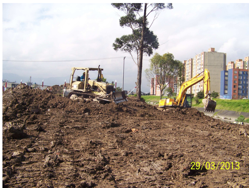
Fuente: Subdirección de Control Ambiental al Sector Público (Secretaría distrital de Ambiente, 2013)
