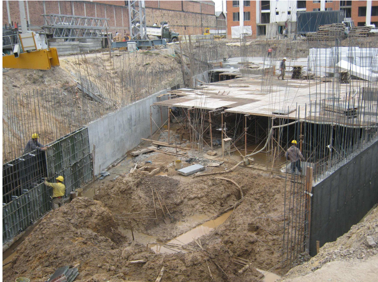
Foto 3. Frente de obra, Localidad de Kennedy
