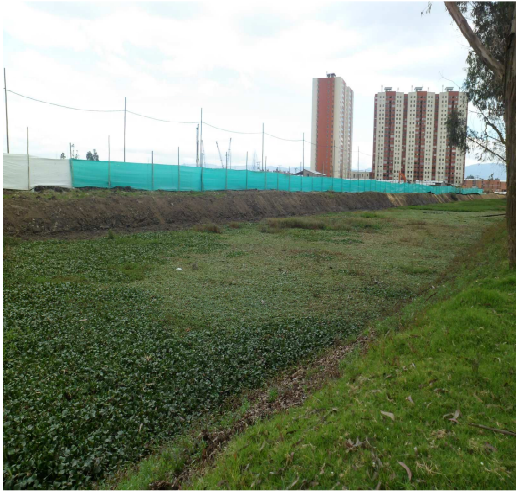
Foto 12. Cerramiento del frente de obra hacia EEP
